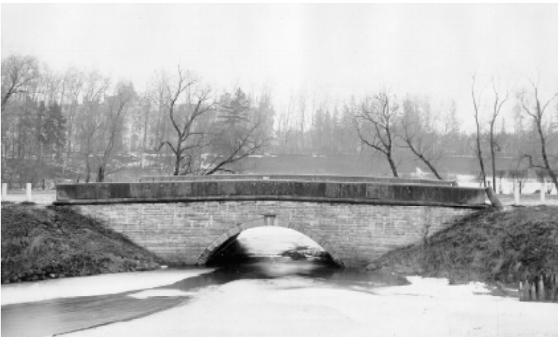
Мост в Стрельне на шоссе Санкт-Петербург–Петергоф, построенный в 1770-х гг. Фотография первой трети XX в. Мост разрушен в годы Великой Отечественной войны.
