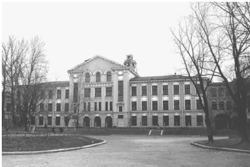
Лицевой фасад главного лабораторного корпуса. Вид со стороны Юсуповского сада. Фотография. 1996 г.
