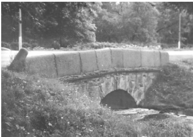
Мост на шоссе Санкт-Петербург–Петергоф неподалеку от Стрельны. Построен в 1770-х гг. Фотография автора. 1981 г.
