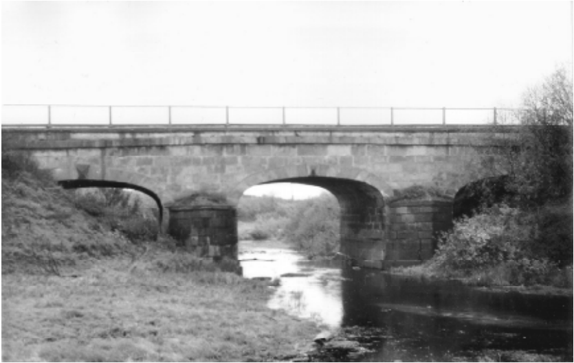
Мост через реку Виточку на шоссе Санкт-Петербург–Москва, построенный в конце XVIII в. в соответствии с типовым проектом 1786 г.
