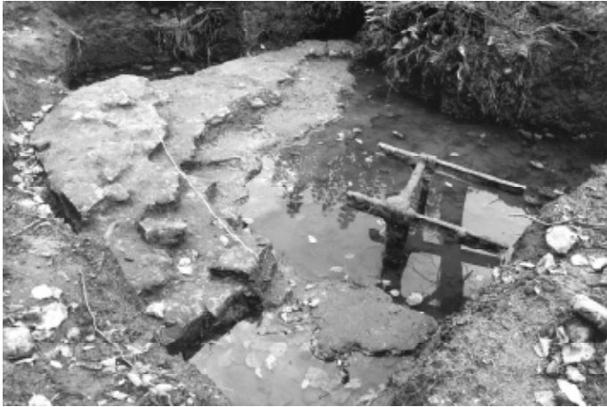
Общий вид фундамента часовни. Фотография. 1997 г.
